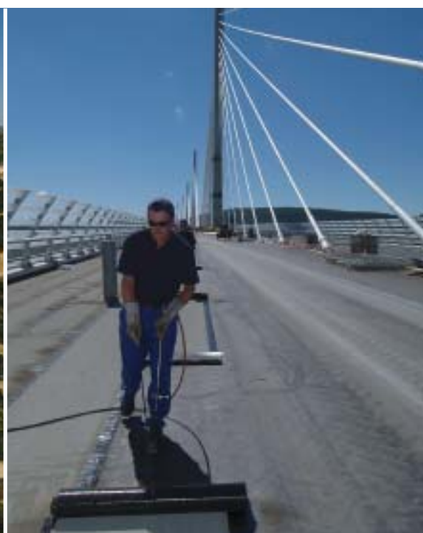
Parafor Pons Dettaglio applicazione manuale
