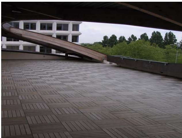
Terrazza in legno con pavimentazione DALLEES BOISE
