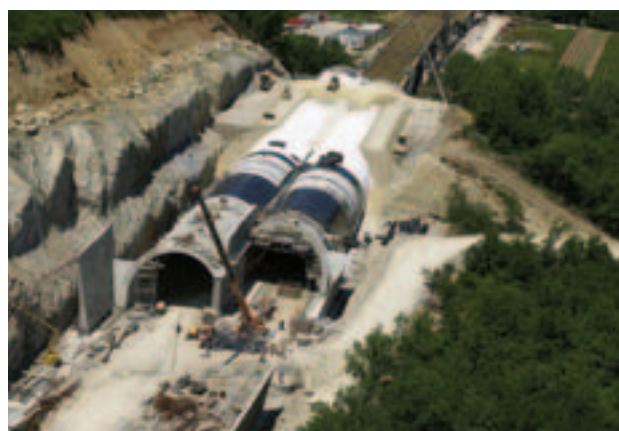
Estradosso di Gallerie artificiali
