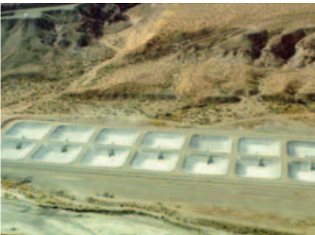
Vasche di decantazione ed evaporazione
