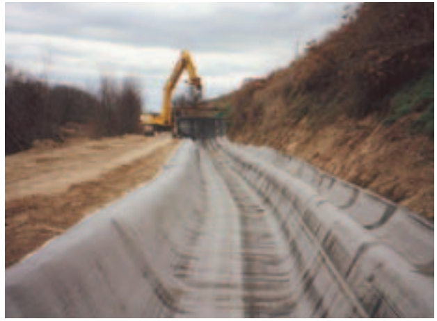
Canali di irrigazione
