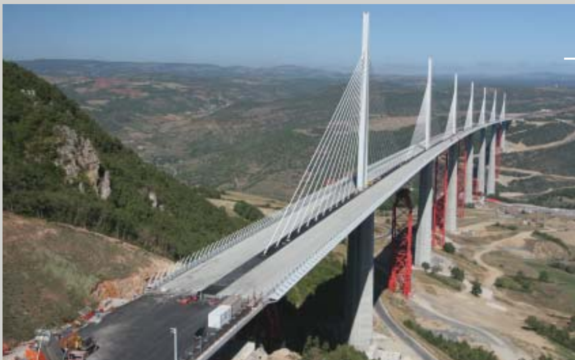
Viadotto di Millau, Francia
