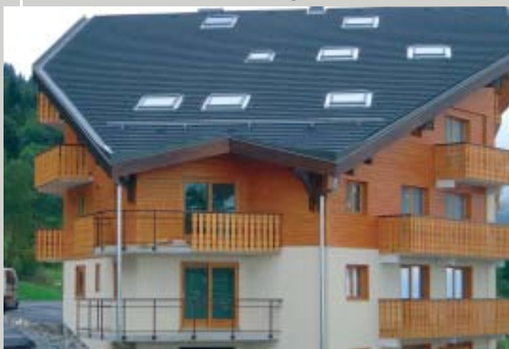
Protezione delle strutture in legno
