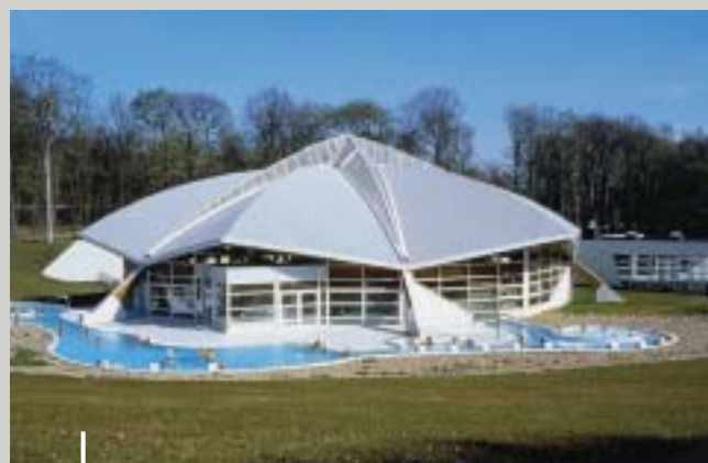
Copertura a volta, parco acquatico
