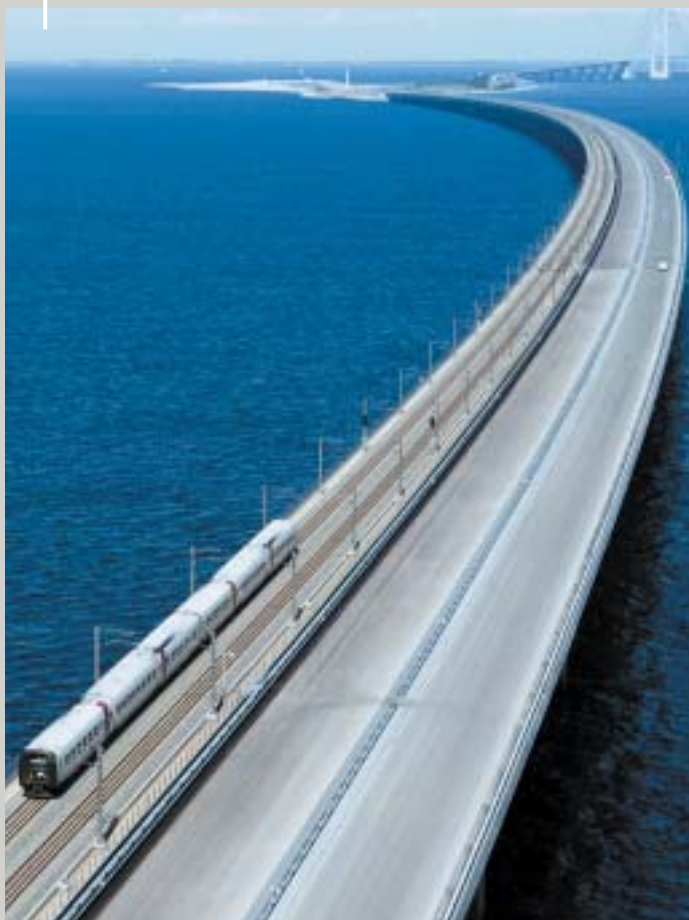
Ponte dell'Oresund, Danimarca
