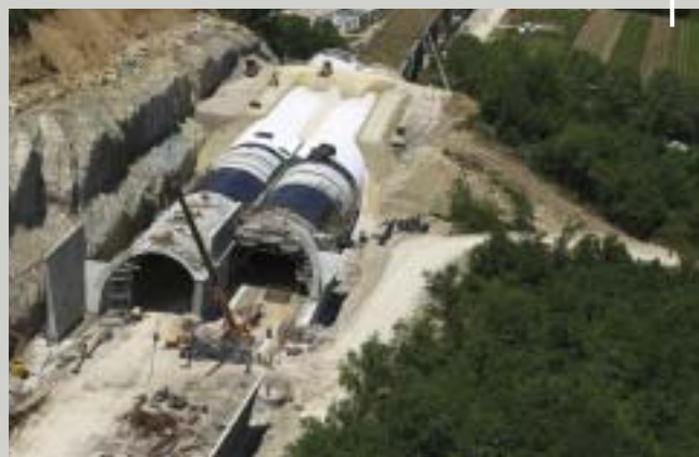
Galleria la Garenne Autostrada A20, Francia
