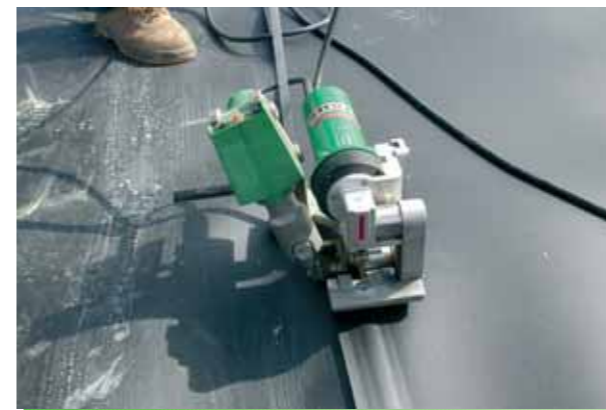
Saldatura con attrezzatura semiautomatica
