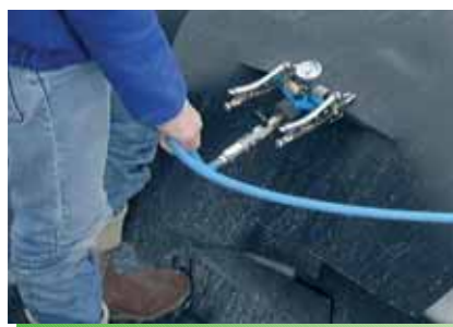
Controlli doppia saldatura a canale centrale
