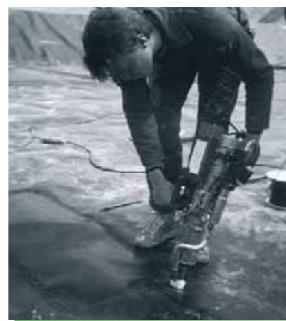
Saldatura per estrusione
